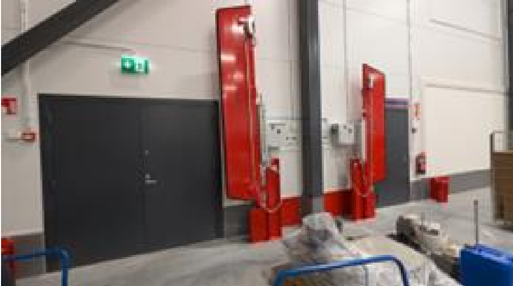
Kuva 15. Vuotosuojapuomirakenne hallitilassa.
