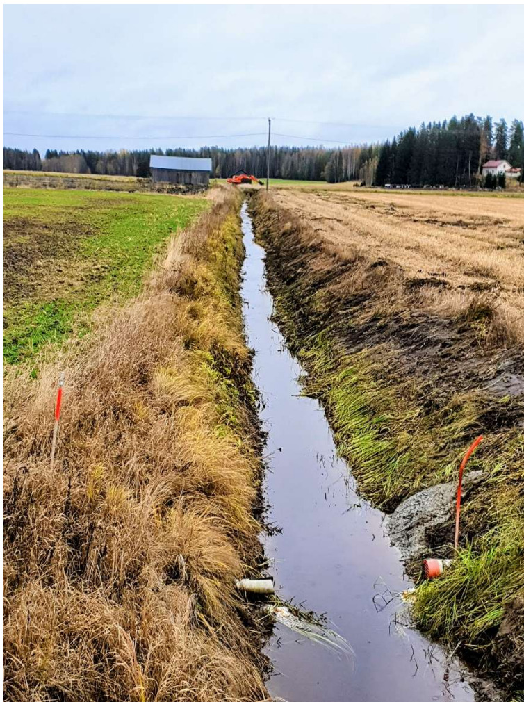
Kuva 4. Hakkarinoja kuvattuna kohdealueen pohjoispuolen peltoaukealta. Etualalla näkyy kaksi salaojaputkea, joista virtaa vesi ojaan. Kuvasta on niin ikään havainnoitavissa pellon ja ojan välinen hyvin kapea suojavyöhyke.
