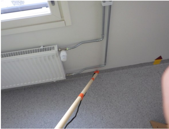
Kuva 38, Merkkiainekeasu laskettiin ulkoseinän eristetilaan ulkopuolelta kuvassa arvioita esitetyltä alueelta
