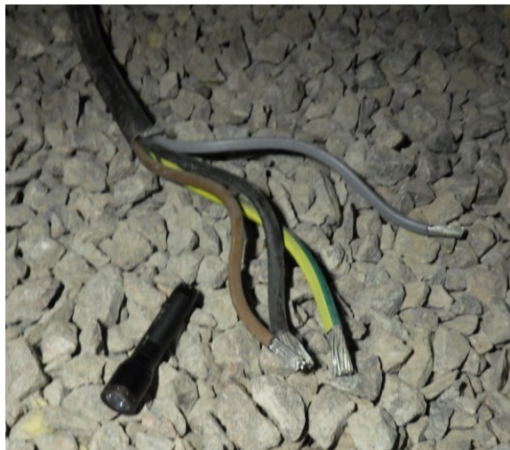
Kuva 6, Kuorittu ja avonaiset sähkökaapelin päät
