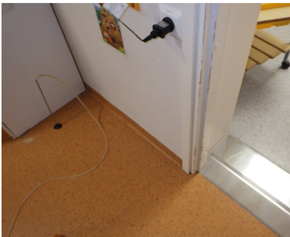
Kuva 47, Merkkiaine laskettiin ylemmään eristekerrokseen
