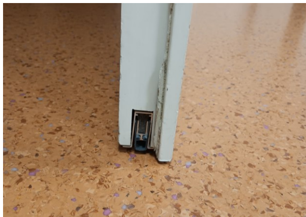
Kuva 33, Oven alareunassa oleva jumittava paloa rajoittava lista
