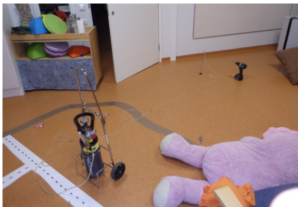
Kuva 44, Merkkiaine laskettiin ylempään eristekerrokseen
