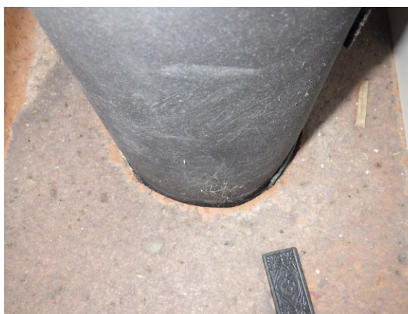
Kuva 56, Tilan 117 nurkassa olevan tuuletusputken läpivienti
