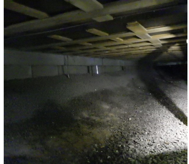
Kuva 3, Tuulettuvan alapohjan maanpinta on ympäröivää maanpintaa alempana
