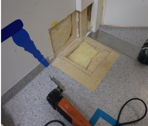
Kuva 58, Rakennavaus RA3 sijaitsee elementtien välisessä kulmassa
