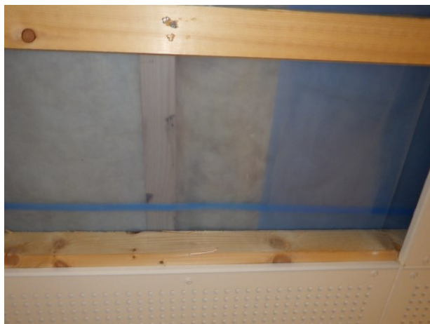
Kuva 23, Eristevillan, puurangan ja höyrynsulun väliseen nurkkaan jää ilmalle tila liikkua
