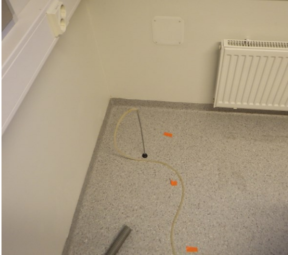
Kuva 34, MA1 merkkiainekaasu laskettu ylempään eristetilaan
