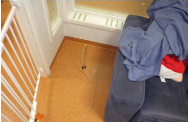
Kuva 46, Merkkiaine laskettiin ylemmään eristekerrokseen
