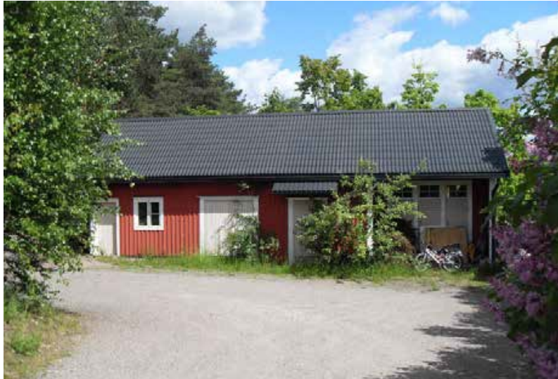
Sivurakennus, entinen sauna & vaja. Anne Vähätalo (2014)
