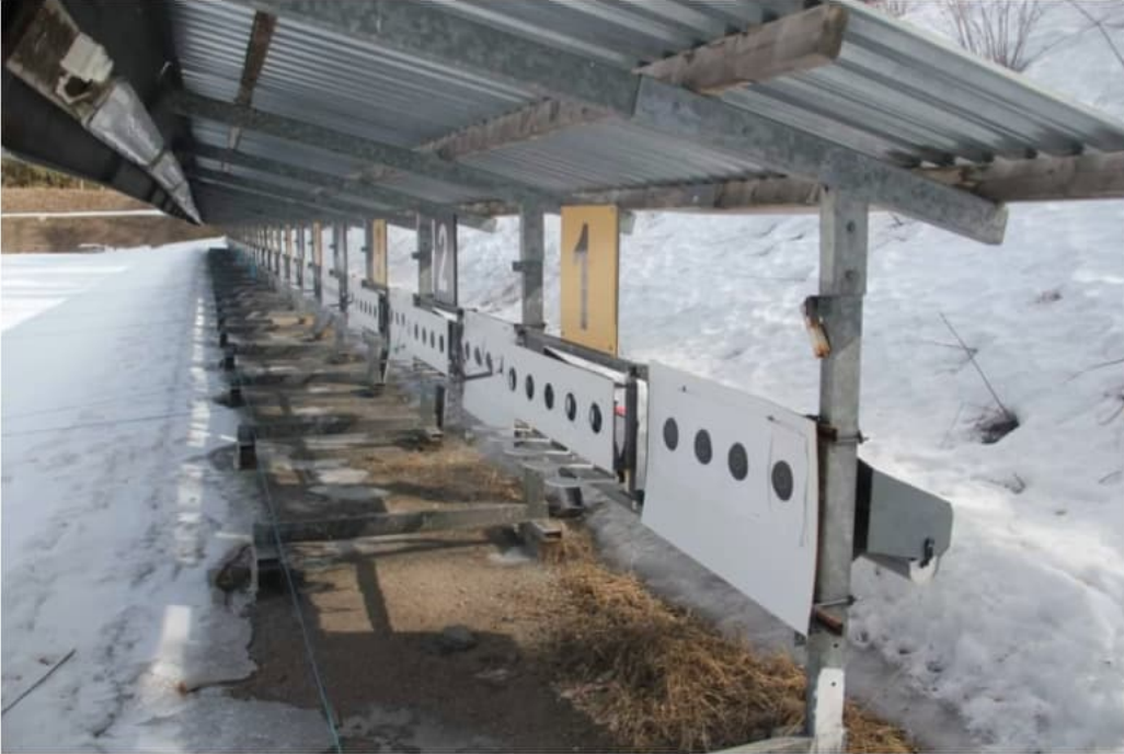
Kuva 13. Tuusulan ampumahiihtostadion taululaitteisto ja -alue (Ampumaratahanke, 2024).
