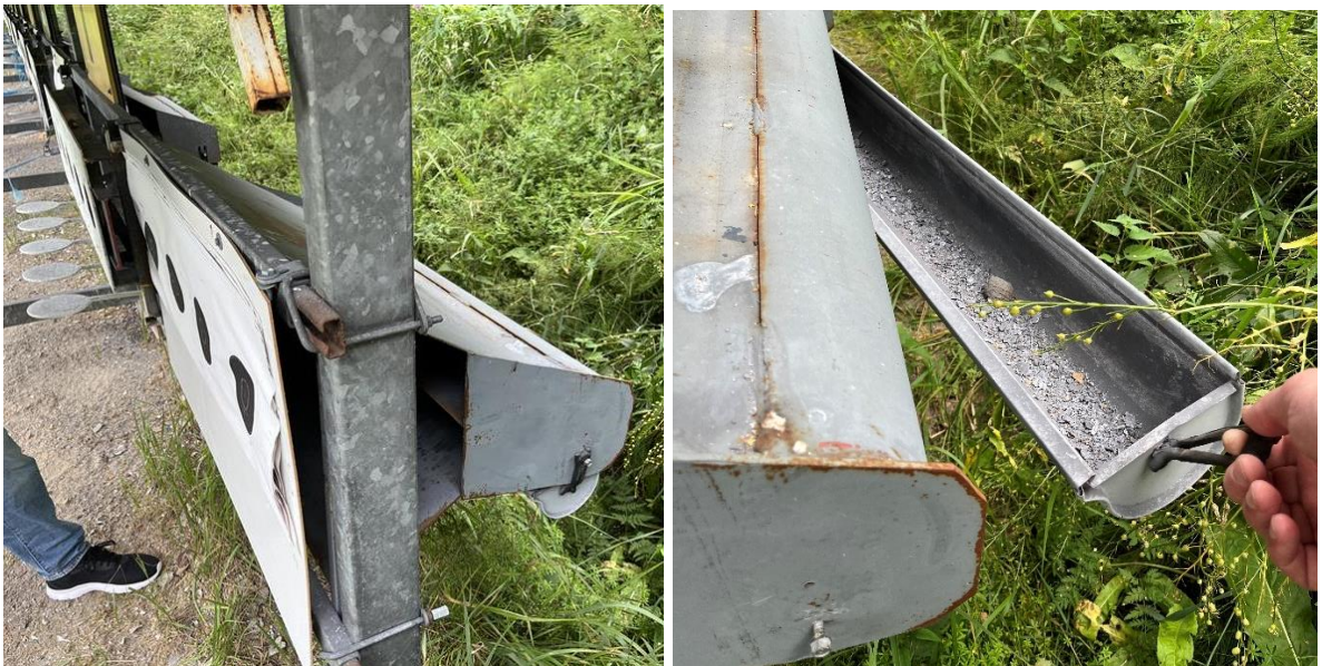
Kuva 3-3. Paperisten ampumataulujen luotien keräyskourut.
