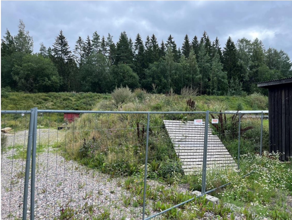
Kuva 2-4: Vuoden 2018 määräaikaistarkistuksen jälkeen rakennettu välivalli. Taustalla näkyy aiemmin rakennettu taustavalli.
