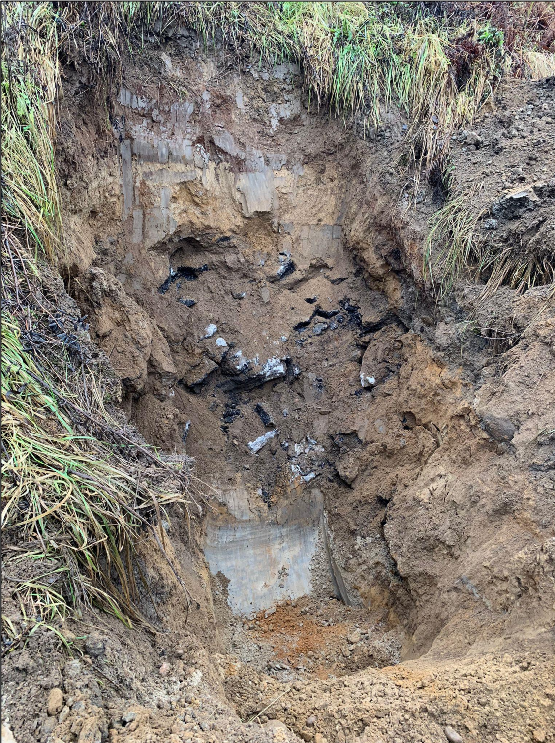
Kuva 3. Koekuopassa SE7 havaittiin asfalttia ja raudoitettua betonia.
