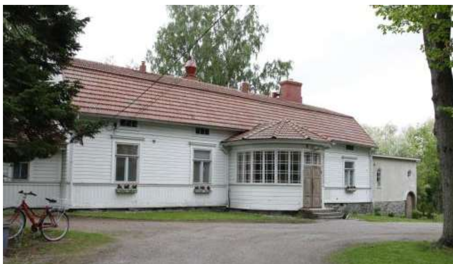
Kuva: Pappilan päärakennus. (Tuusulan kunta)
