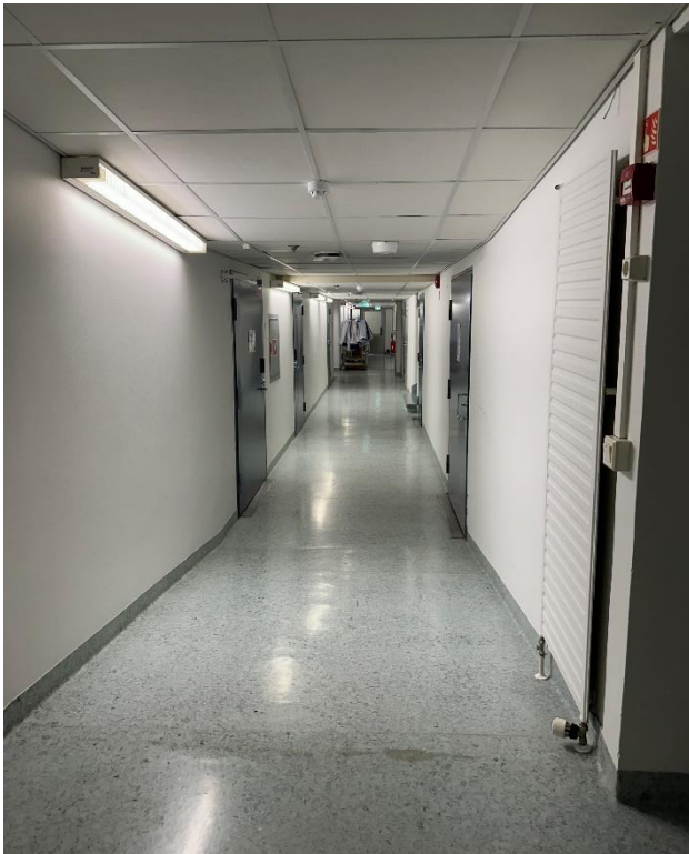
Kuva 186. C-osa, pohjakerroksen käytävä.
