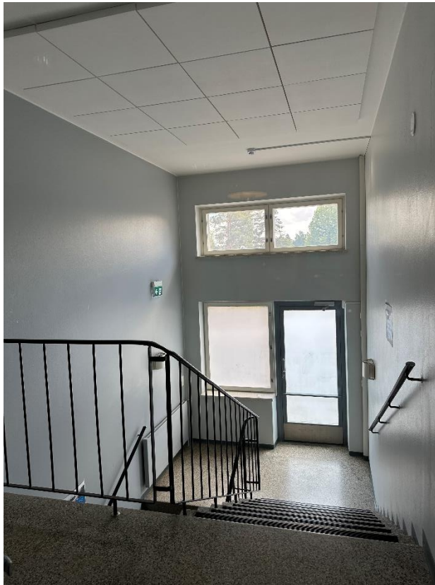
Kuva 164. D-osa, 2. kerroksen päädyn porrashuone.
