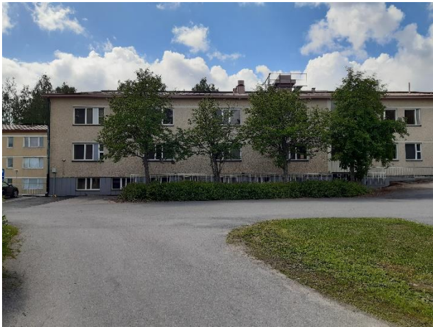
Kuva 126. D-osan julkisivu idästä katsottuna.
