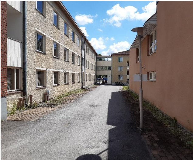
Kuva 147. B- ja D-osien sisäpiha lounaaseen.
