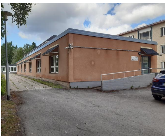
Kuva 143. B-osan lounainen julkisivu
