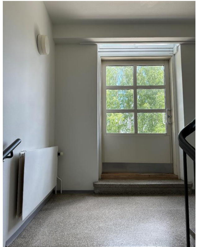
Kuva 179. C-osa, parvekkeen ovi porrashuoneessa.
