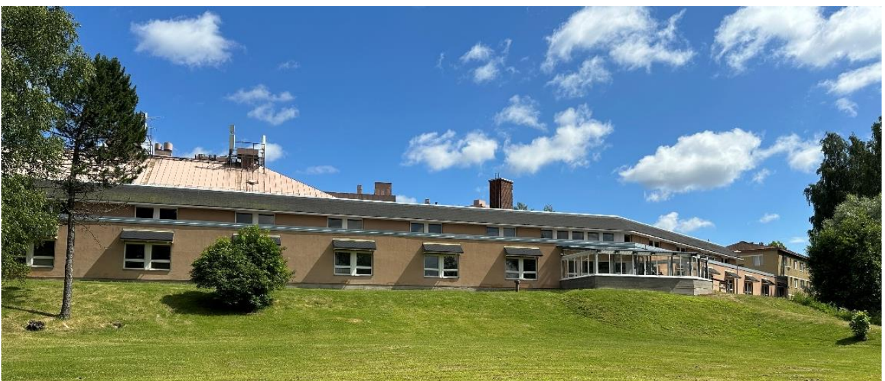
Kuva 140. A- ja B-osien julkisivu länteen
