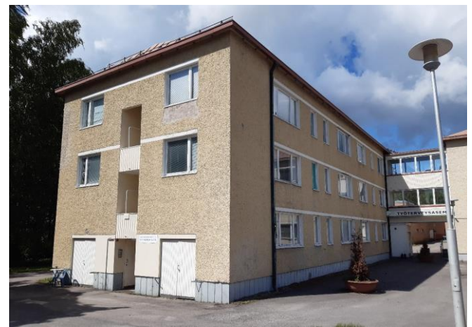
Kuva 152. Asuinrakennuksen julkisivut koilliseen ja kaakkoon
