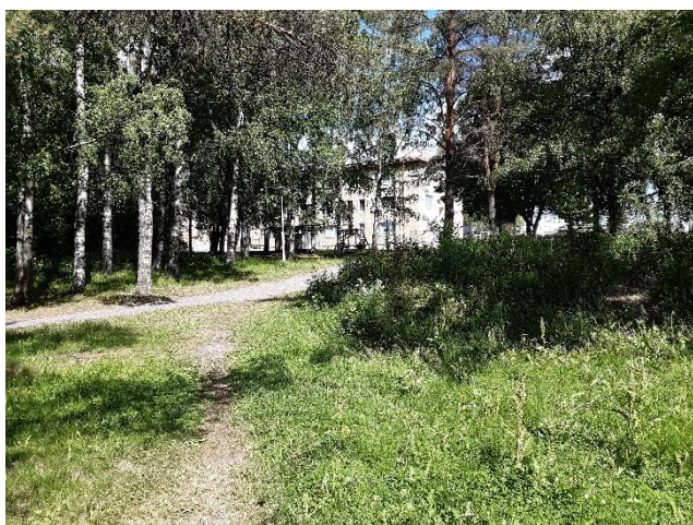
Kuva 116. Asuinrakennus metsäalueen halki katsottuna lännestä päin.
