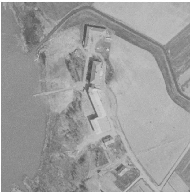
Kuva 22. Ilmakuva vuonna 1965. Lähde: Paikkatietoikkuna
