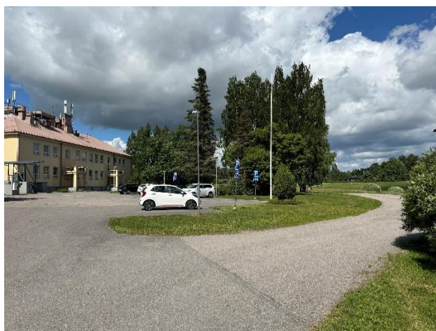
Kuva 125. Rakennusten pohjoispuolella olevalle pysäköintialueelle vievän ajoradan alkupää pääsisäänkäynnin edustalla etelästä katsottuna.
