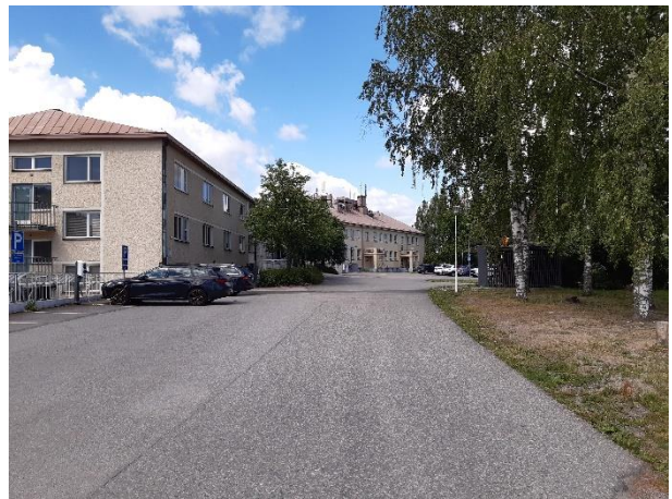
Kuva 99. Näkymä Kotorannankujalta luoteeseen kohti Tuuskodon itäistä julkisivua, edessä vasemmalla D-osa, keskellä taustalla vanha päärakennus, C-osa.
