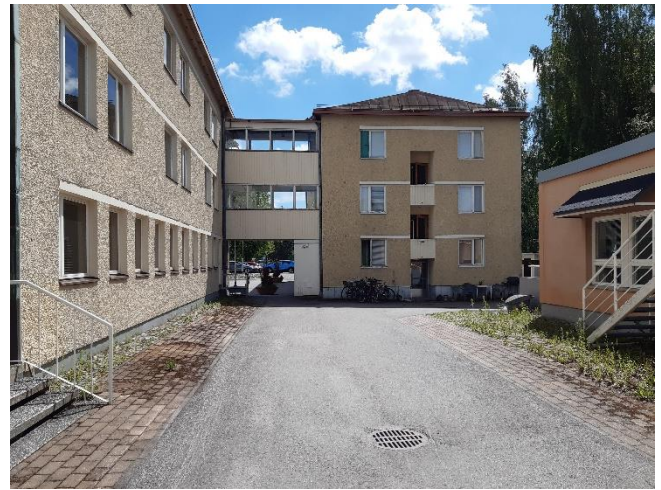
Kuva 150. D-osan lounainen julkisivu ja asuinrakennuksen luoteinen julkisivu.
