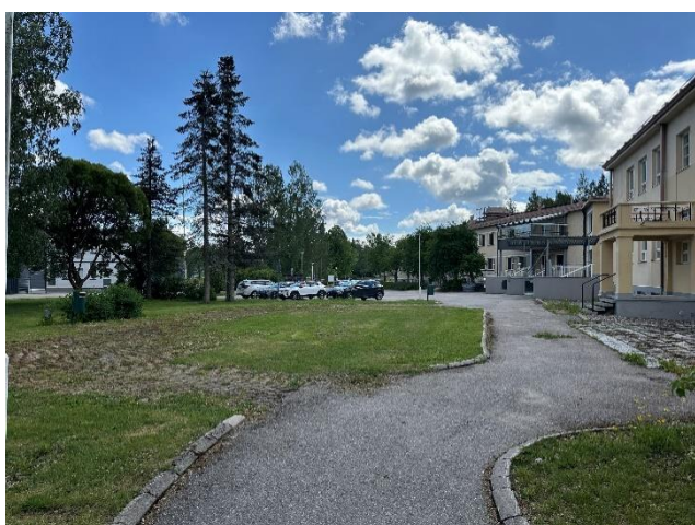
Kuva 91. C-osan edustalta näkymät etelään päin.
