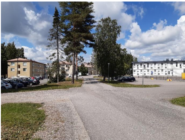
Kuva 98. Näkymä Kotorannankujalta luoteeseen kohti Tuuskotoa. Oikealla väliaikainen koulurakennus, vasemmalla asuinrakennus.
