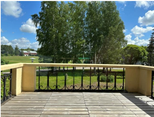
Kuva 133. C-osan 1. kerroksen parveke
