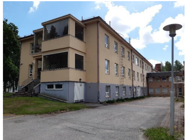
Kuva 134. C-osan pohjois- ja länsijulkisivut
