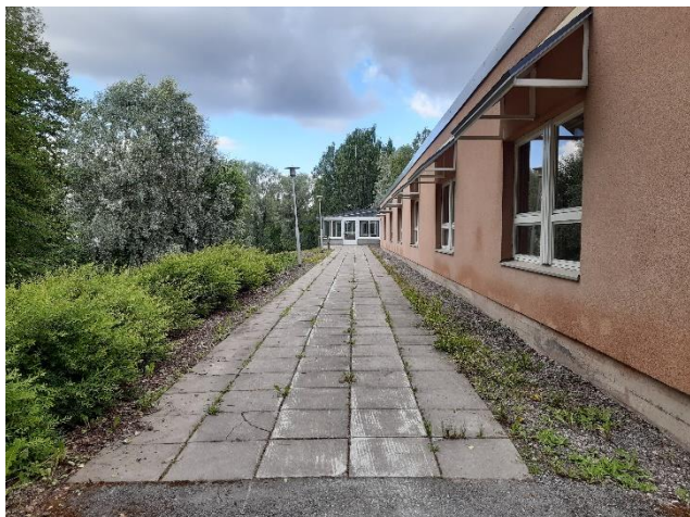
Kuva 118. B-osan länsipuolen julkisivua ja julkisivun edustan laatoitusta etelästä katsottuna.
