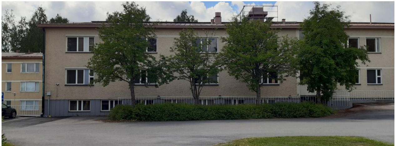
Kuva 155. D-osan julkisivu koilliseen.
