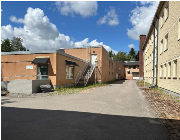
Kuva 149. B- ja D-osien sisäpiha luoteeseen.
