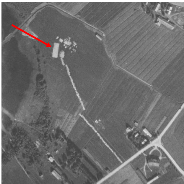
Kuva 17. Ilmakuva rakentumisen alkua ajoilta vuonna 1931. Lähde: Paikkatietoikkuna
