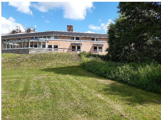
Kuva 114. A- ja B-osien julkisivujen kulma lännestä katsottuna.
