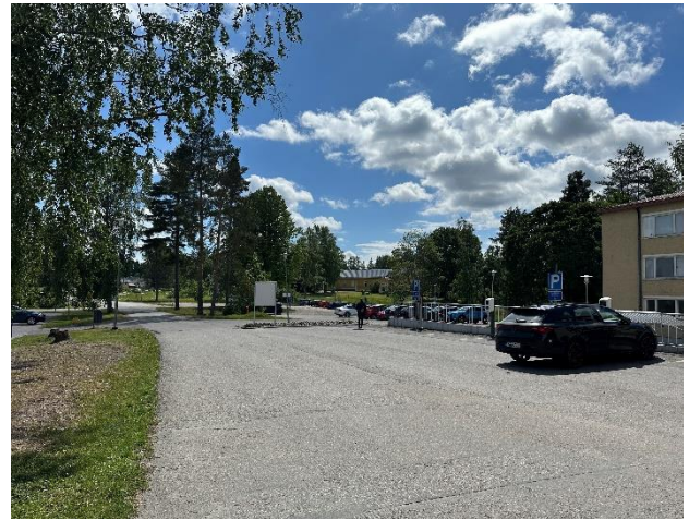
Kuva 127. Kotorannankujan pohjoispää pohjoisesta katsottuna. Oikealla D-osaa.
