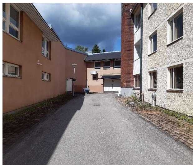
Kuva 144. B- ja D-osien sisäpiha luoteeseen
