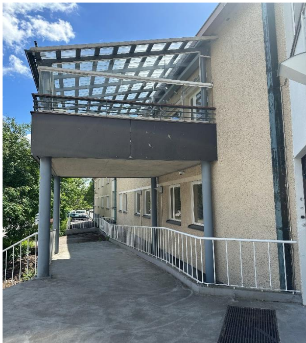
Kuva 159. D-osan koillisen julkisivun parveke.
