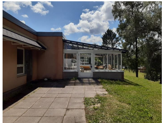
Kuva 109. A-osan luoteisnurkan kivetystä ja länsijulkisivun katettu terassi pohjoisesta katsottuna.
