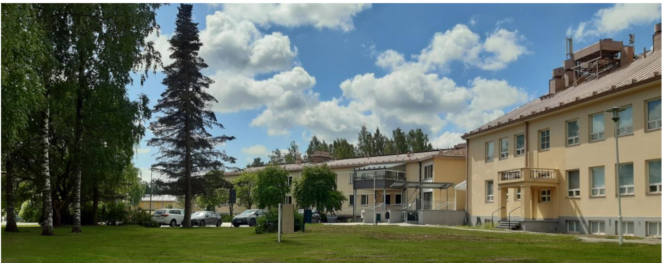
Kuva 101. C-osan itäisen julkisivun edustaa.
