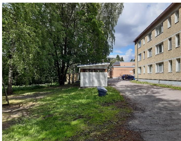
Kuva 117. Asuinrakennuksen länsipuolen julkisivui etelästä katsottuna.
