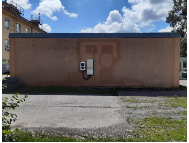
Kuva 138. A-osan julkisivu pohjoiseen.
