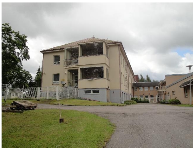
Kuva 49. Tuuskodon C-osan pohjoispäätä ja pohjoista sisäpihaa vuonna 2014. Lähde: RVA
