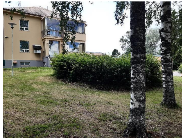
Kuva 105. C-osan pohjoispääty koillisesta katsottuna.
