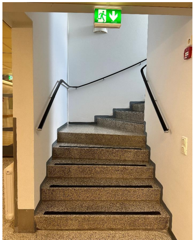
Kuva 167. D-osa, pohjakerroksen portaat.
