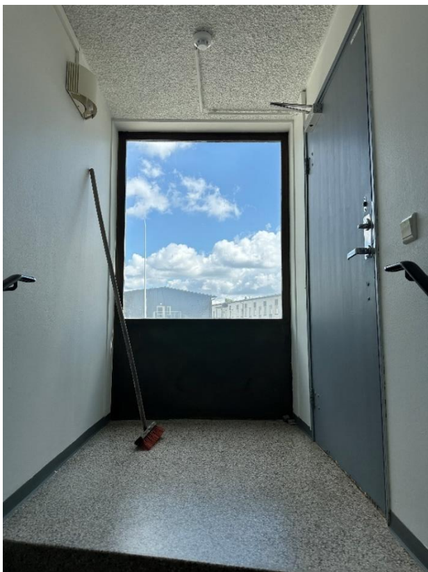
Kuva 168. D-osa, ummistettu uloskäytävä portaiden päässä.
