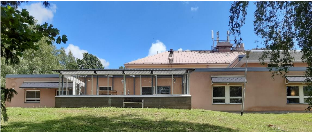
Kuva 139. A-osan julkisivu länteen.
