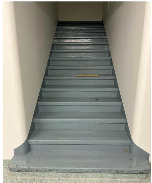
Kuva 181. C-osa, pohjakerroksen ummistetut portaat.
