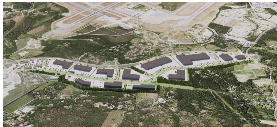
Havainnekuva pohjoisesta etelään, Sitowise, 2025
