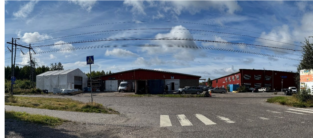
Kuva 9. Panoraamakuva. Puusepätien teollisuusalueen hallirakentamista alueen itäosissa.
