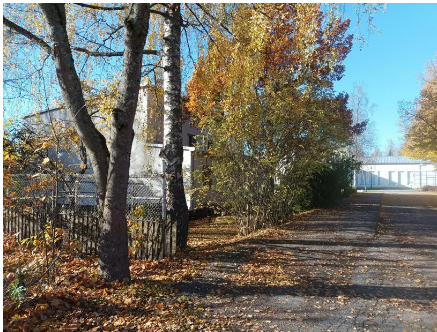
Kuva 10: Opettajien asuntolarakennuksen itäjulkisivu yleiseltä kevyen liikenteen väylältä kuvattuna pelikentän suunnalta (kuva otettu 17.10.2025)
