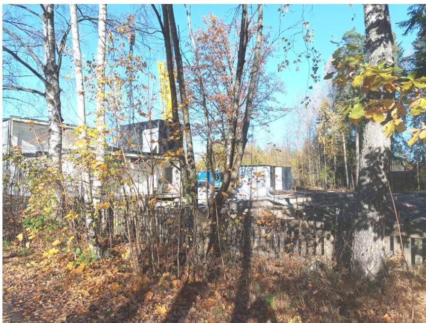
Kuva 4: Kiinteistön 858-402-1-145 aluetta, jolla sijainnutta parakkikoulua purettiin. Tontin reunoilla on säästynyt kookasta puustoa. (kuva otettu 17.10.2025)
