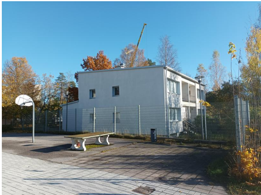
Kuva 9: Opettajien asuntolarakennuksen länsijulkisivu ja parvekeseinä (kuva otettu 17.10.2025)
