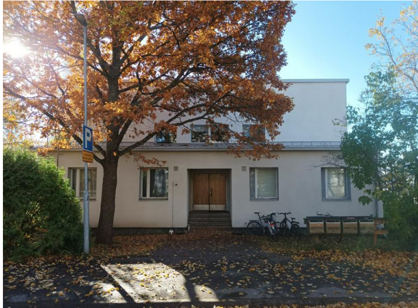
Kuva 8: Opettajien asuntolarakennuksen pohjoisjulkisivu ja pääsisäänkäynti (kuva otettu 17.10.2025)
