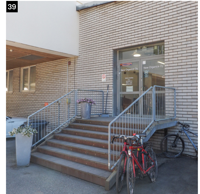
↑ Tehdassalin toinen sisäänkäynti on myöhempi lisäys.
