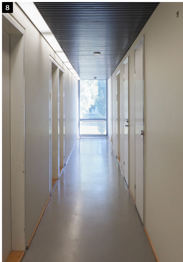
↑ Toimistokäytävien pintamateriaalit toistuvat samantyyppisinä. Lattioissa on harmaa linoleumimatto, katoissa alkuperäinen metallisäle ja seinät on maalattu valkoiseksi. Käytävien sivulla kulkee rakennukselle ominainen yhtenäinen valaisinrivistö.
