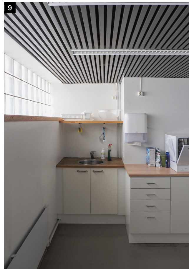
↑ Kolmannen kerroksen aulaan, wc-tilojen väliin on oletettavasti jälkikäteen rakennettu taukotila keittiöineen.
